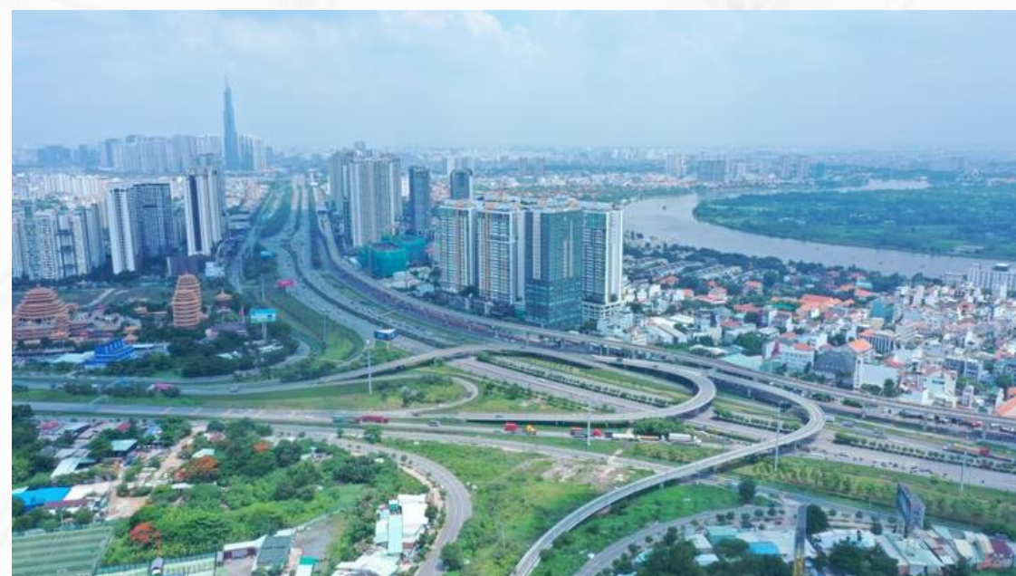
DỰ ÁN MỞ RỘNG XA LỘ HÀ NỘI GIAI ĐOẠN 2
